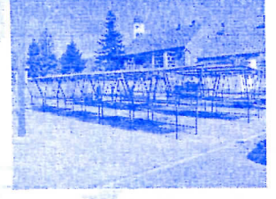
Изграђена зелена пијаца
