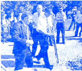
Почетак изградње пута Сурдук-Сланкамен
