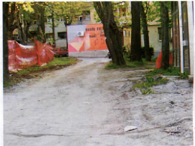
Прилаз згради у улици Генерала Павла Јуришића Штурма бр.6
