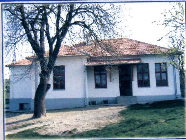
НОВИЗГРАЂЕНА ШКОЛА У КРУШЈУ
