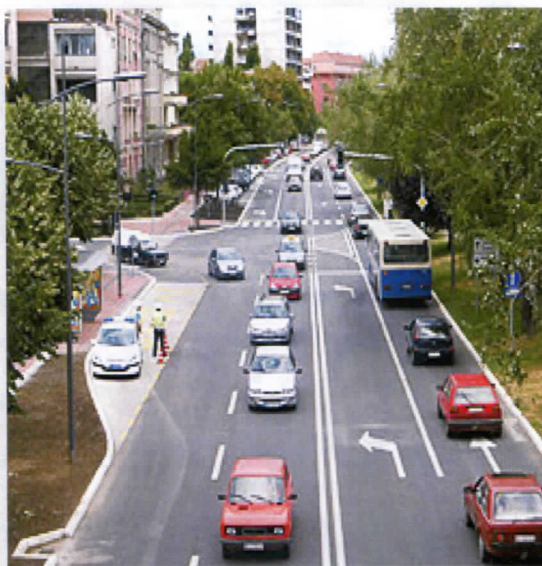
Кеј после реконструкције
