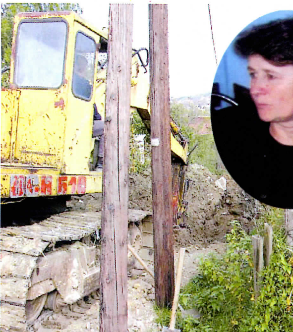
Завршетак водоводне мреже у насељу Драгослава Станковића
