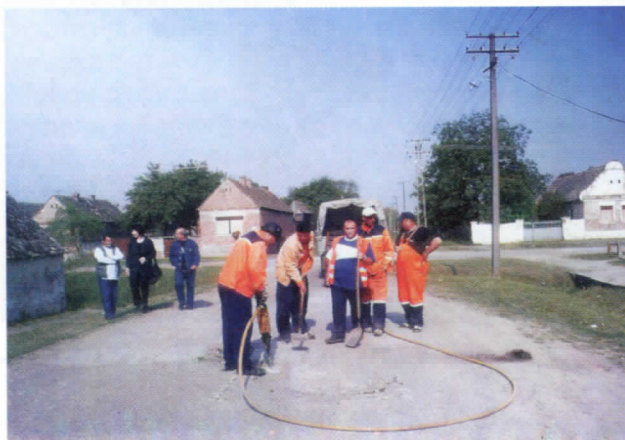
ИЛИНЦИ: Почетак радова на реконструкцији три улице
