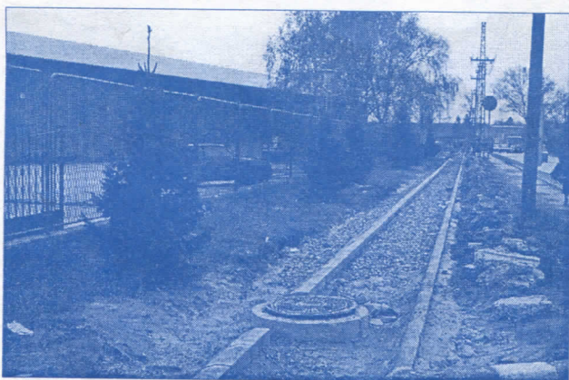
ИЗГРАДЊА КОЛЕКТОРА У ВРБАСУ
