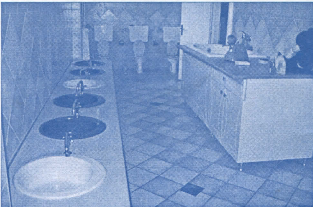
РЕКОНСТРУИСАНИ САНИТАРНИ ЧВОРОВИ У ПРЕДШКОЛСКОЈ УСТАНОВИ "БОШКО БУХА"
