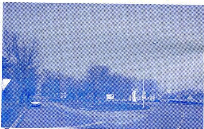
Реконструкција улице Архитекте Брашована
