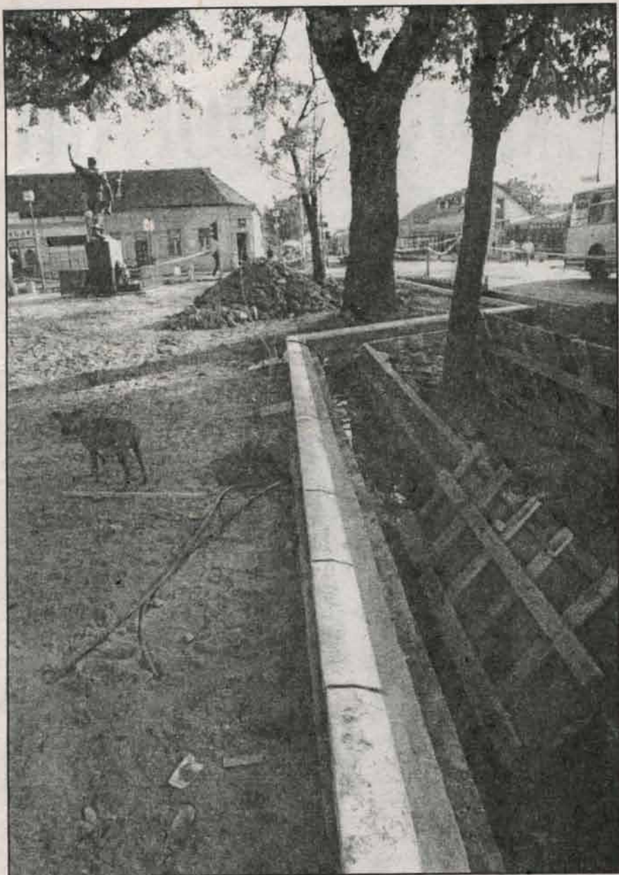
Копају се канали за кишницу и уређују тротоари
