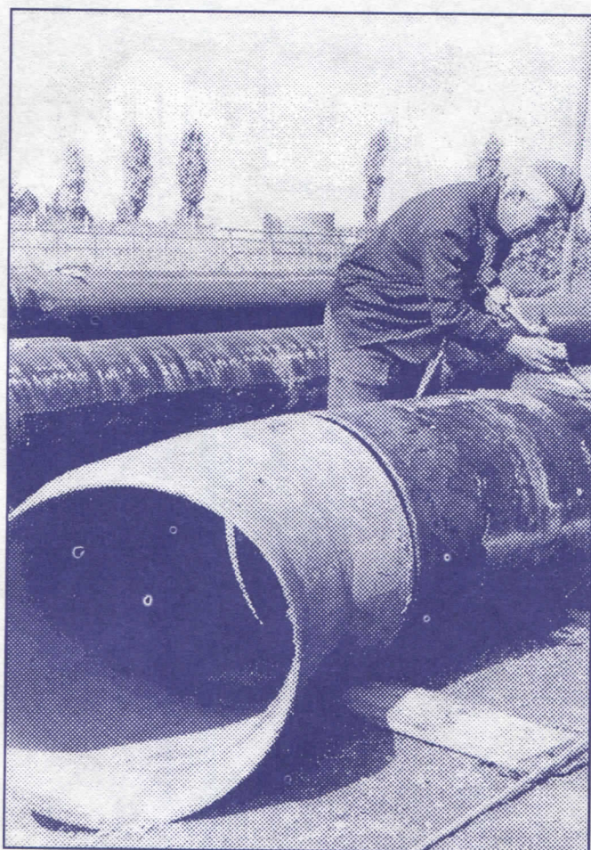
Отклонити слабости водоводног и канализационог система
