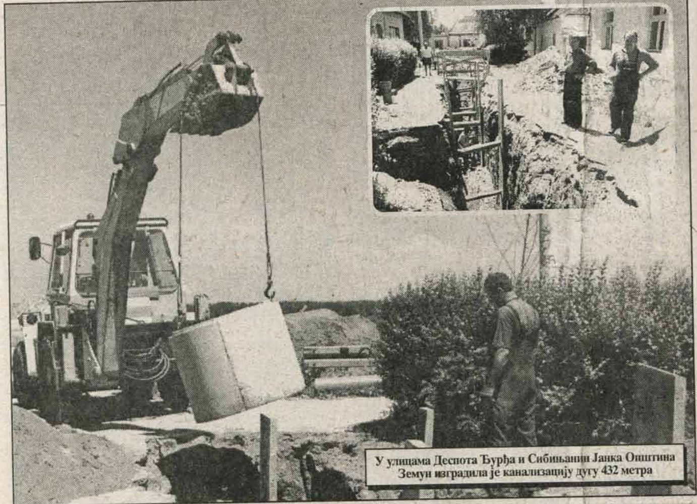
Паралелно са водоводом у насељу Бачки Иловник изграђена је канализација дужине 1638 метара
