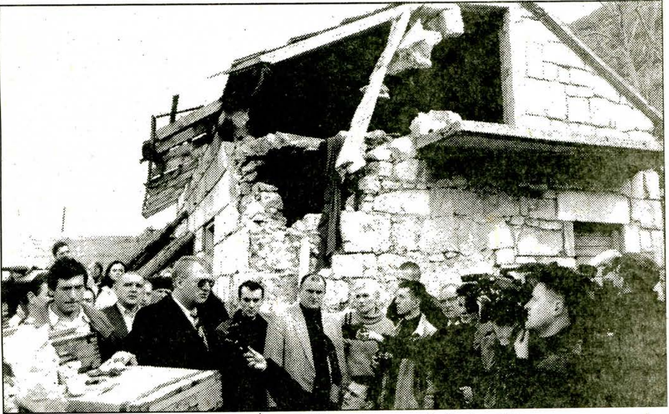
Марева љут – оштећена кућа Шешељевих на првој борбеној линији
