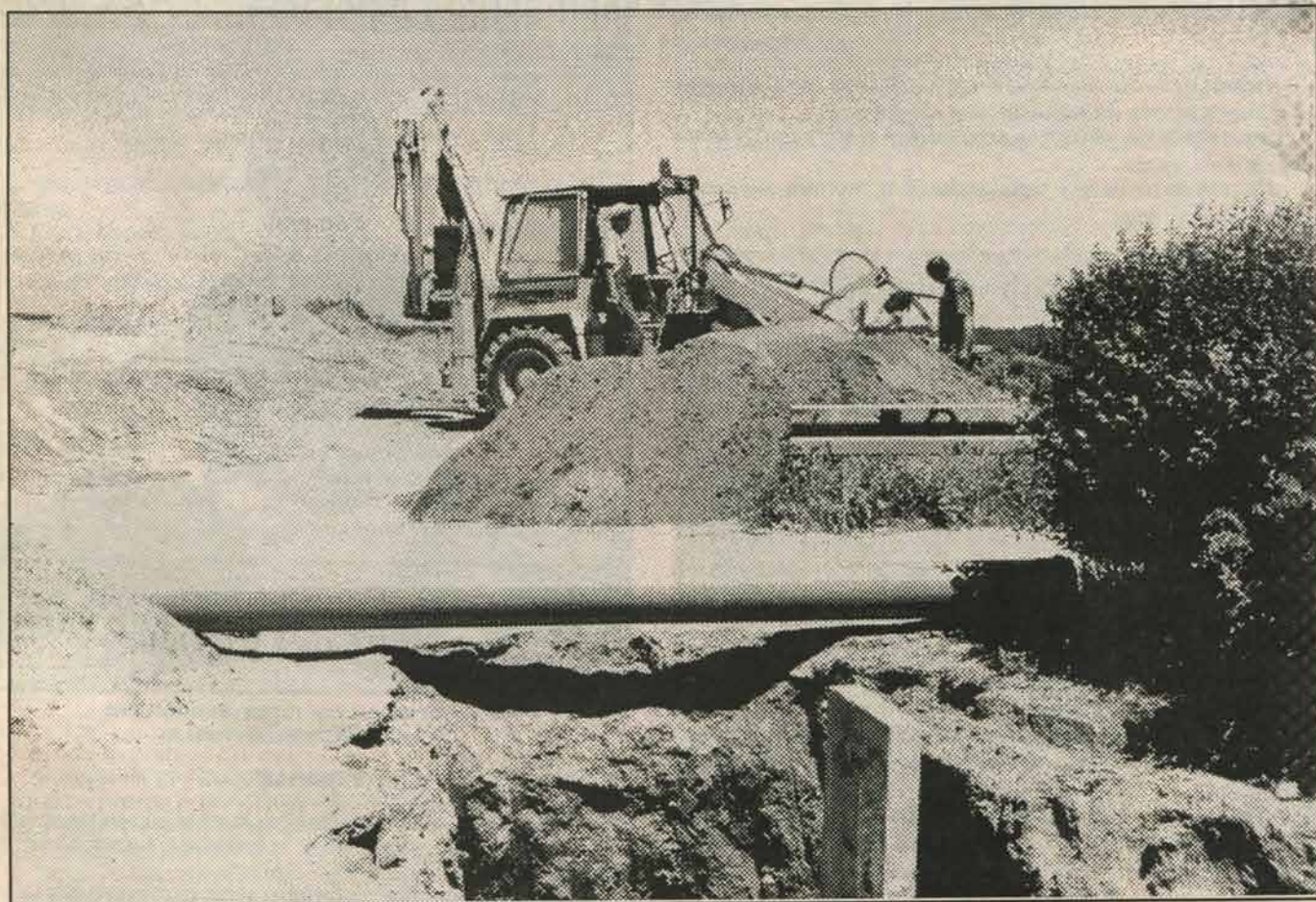
За изградњу нове и ремонтовање дотрајале водоводне мреже
