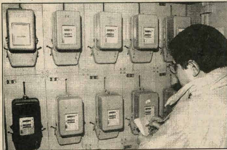
Електрична бројила – непресушни извор прихода СПС-а
